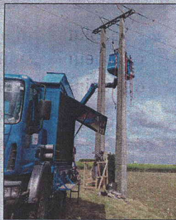
Lors de l'installation de l'interrupteur. PHOTO DR
